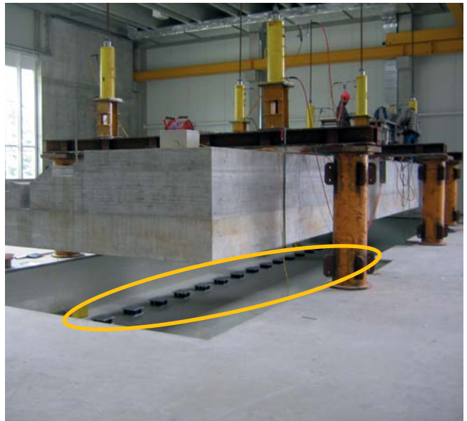
240 t – Fundamentlagerung mit Federpaket V1B1134-87
